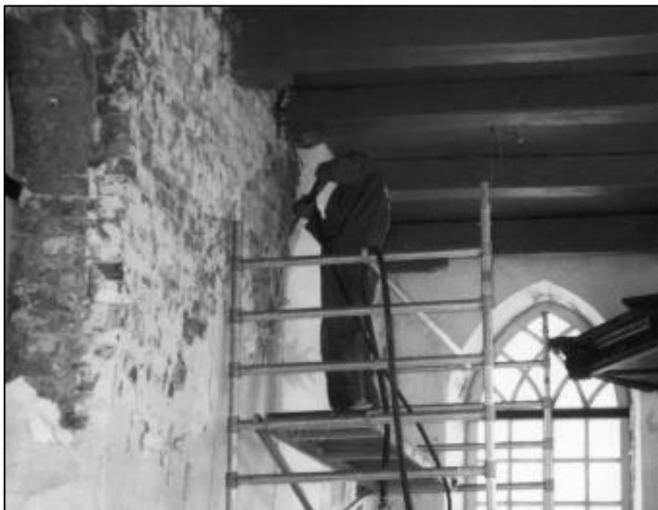
15.1 Het verwijderen van de pleisterlaag. Foto privébezit.
