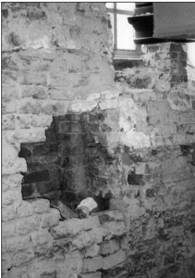
15.2 De middeleeuwse manneningang. Foto privébezit.
