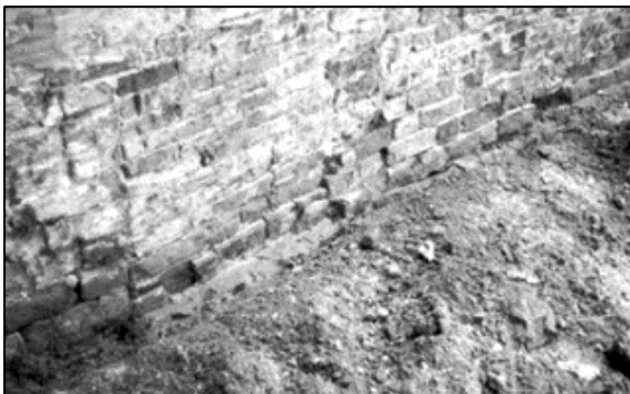
16.3 Kloostermoppen kunnen heel brokkelig worden. Foto privébezit.
